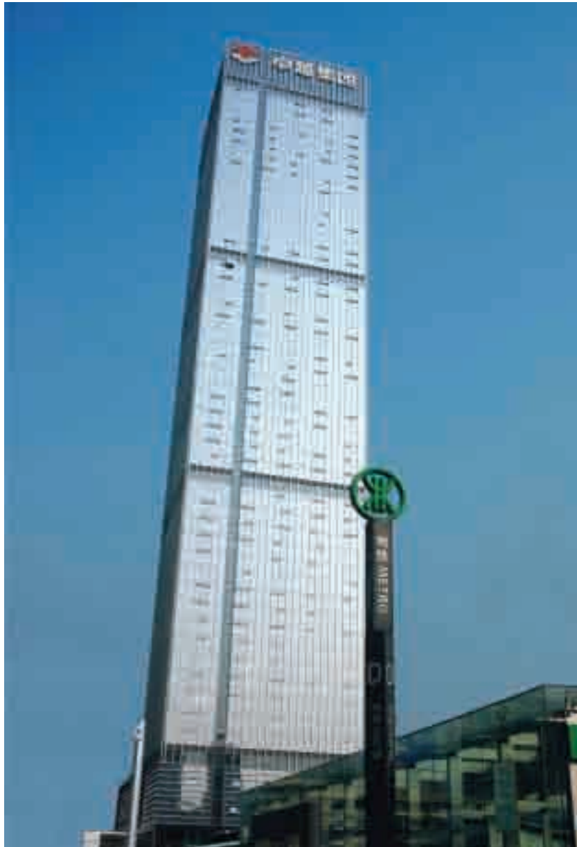
Shenzhen Excellence Times Plaza (Phase 1) (深圳卓越時代廣場一期)
