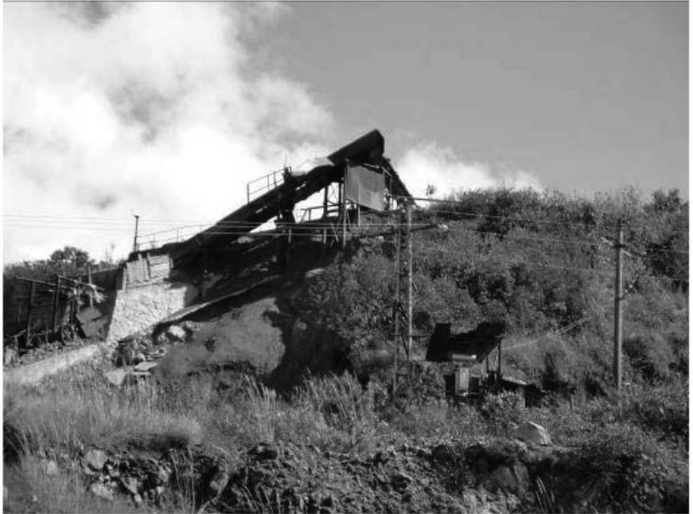
圖7-3 破碎站現場照片
