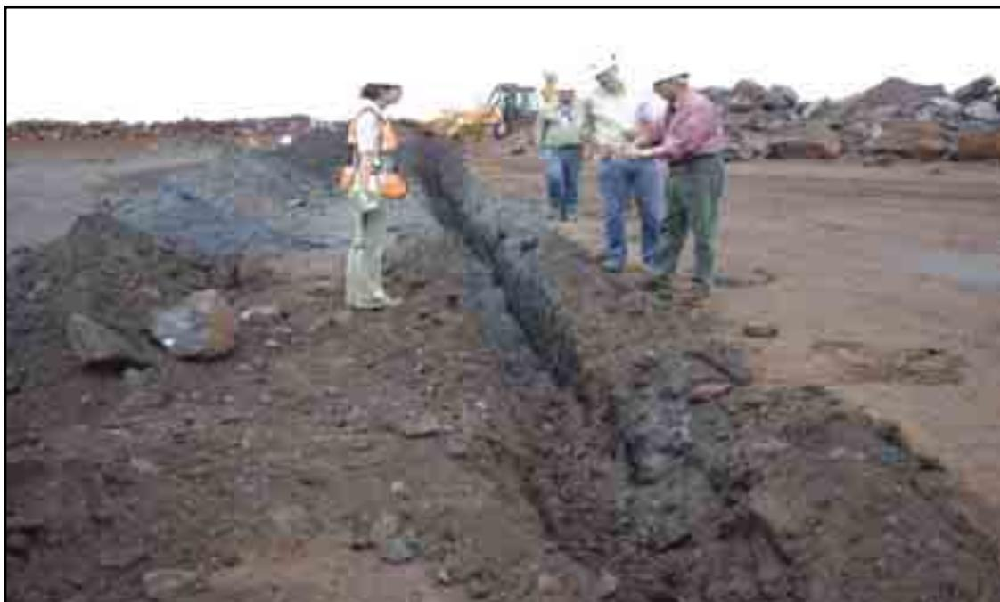
從挖出礦物堆中取出約60公斤同類岩性礦物作為一份樣本。將樣本送往實驗室，進行標準粒度-化學分析。假設探槽樣本的獲取率是100%。CAP探槽的長度標準為3米，而CAN探槽的長度根據挖出礦物的岩性連續度會有所變化。
