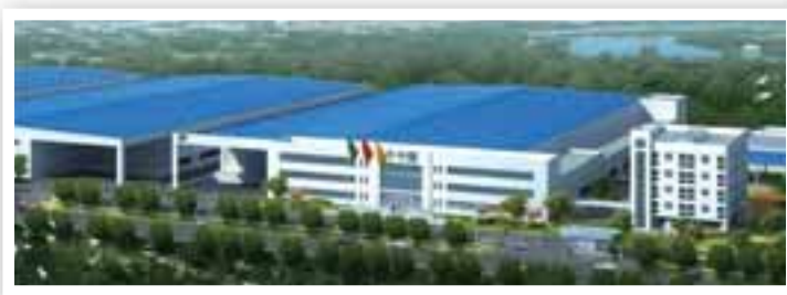
中糧包裝(武漢)有限公司廠房
