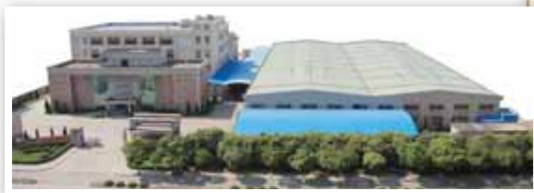
品冠廠房外貌
