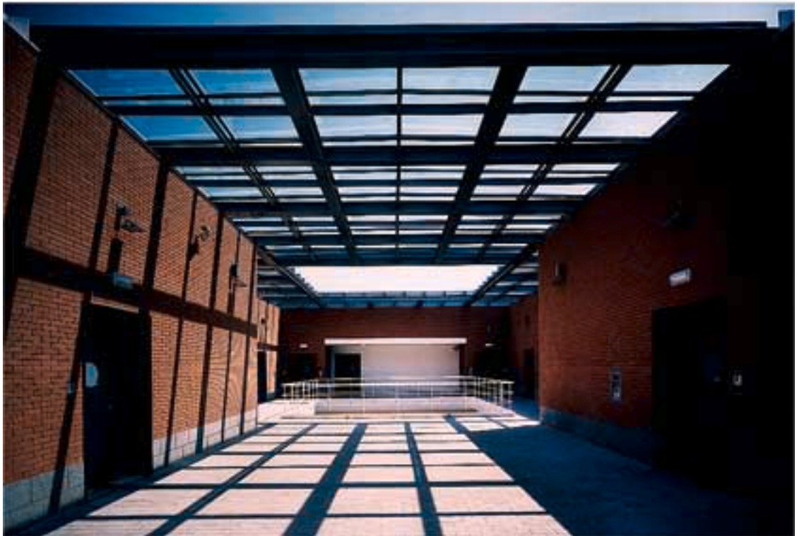
The I.P.I. Amiata facility Piancastagnaio (SI), project by Studio Cerri
