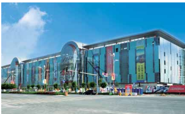
The logistics trade center under construction at CSC Nanning 在建中的南寧華南城物流交易中心
