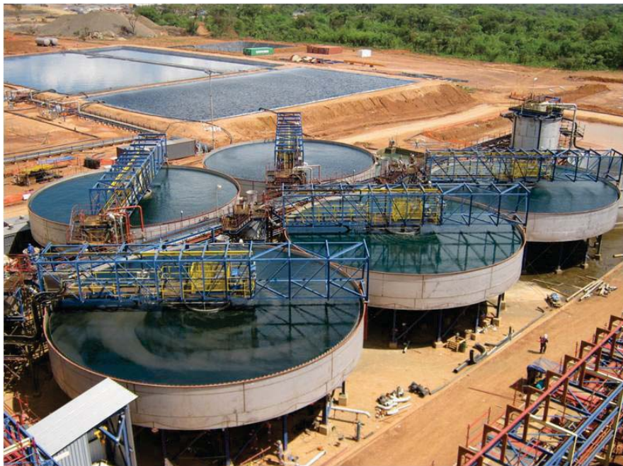
圖 56：封流傾池（CCD）容器，背景是母液溶液（PLS）池
