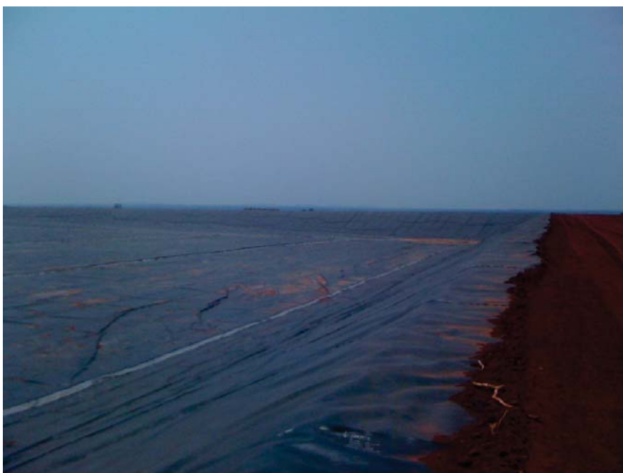
圖 67：從堤岸西側看到的 Mutanda 尾礦壩盆地
