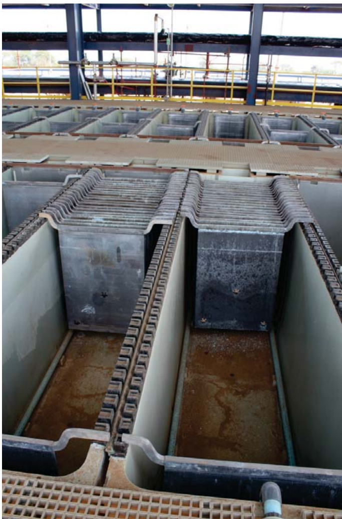
圖 60：建造期間將鉛陽極安裝到電解沉積池
