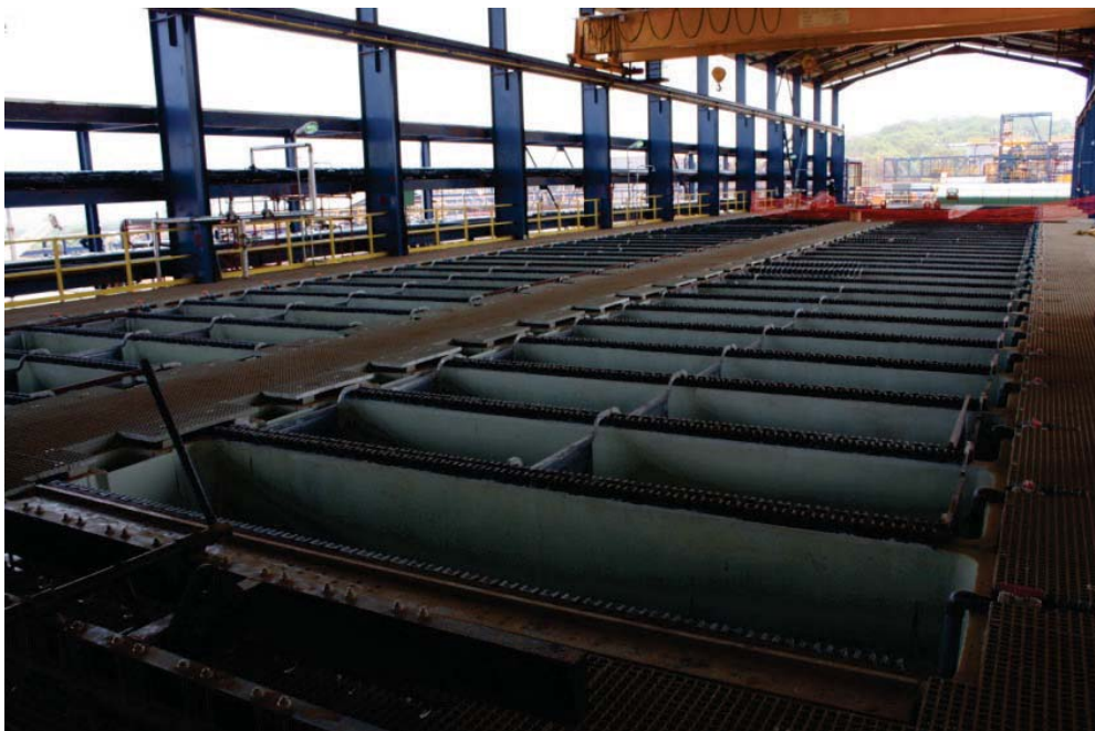
圖 59：建造中的電解車間內部
