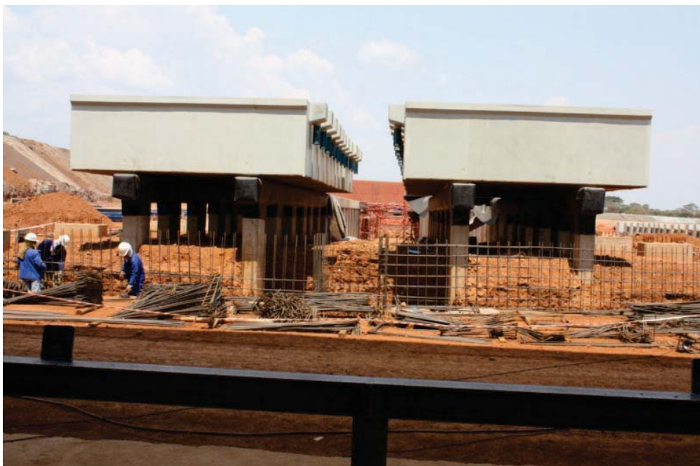
圖 64：40,000 tpa 組合式電解沉積池已經就位
