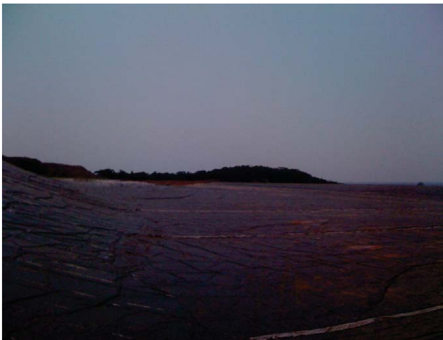
圖 68：襯裡裝設期間的 Mutanda 尾礦壩
