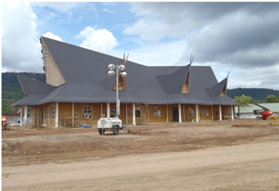
辦公大樓大致竣工
