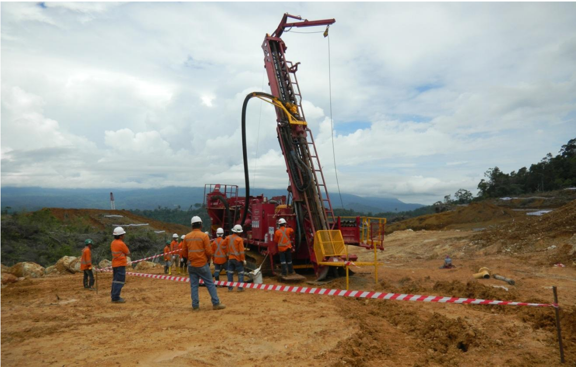
反循環鑽探品位控制鑽機作業中
