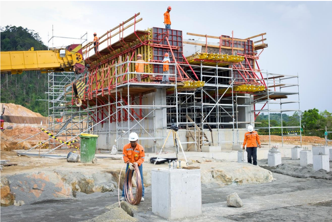
第二破碎機混凝土
