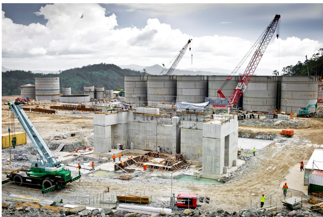
球磨機及半自磨機區混凝土工程
