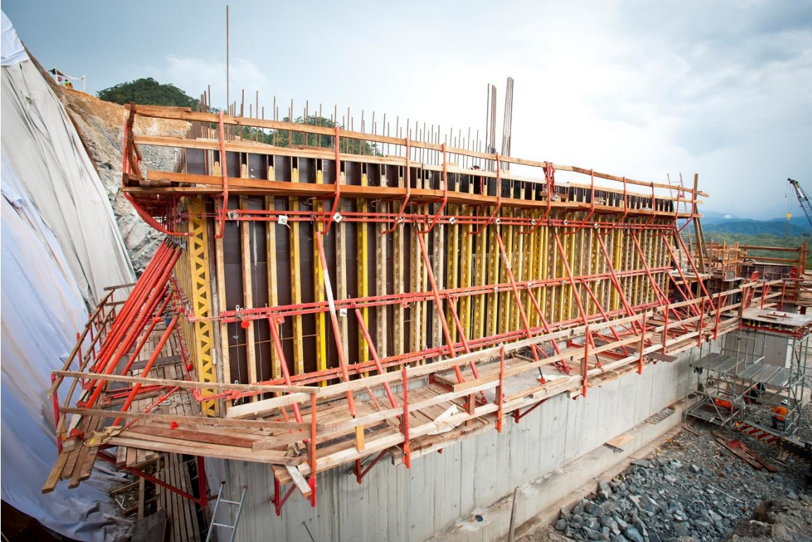
主要破碎機混凝土
