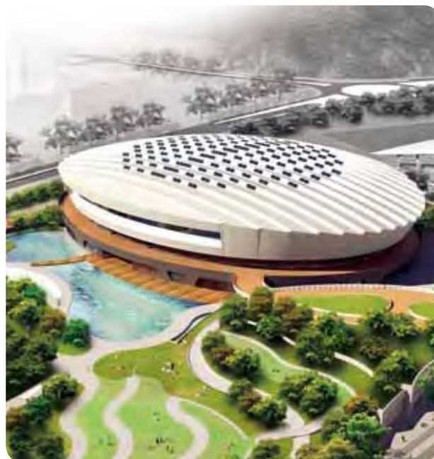
位於香港的市鎮公園、室內單車場及體育館
