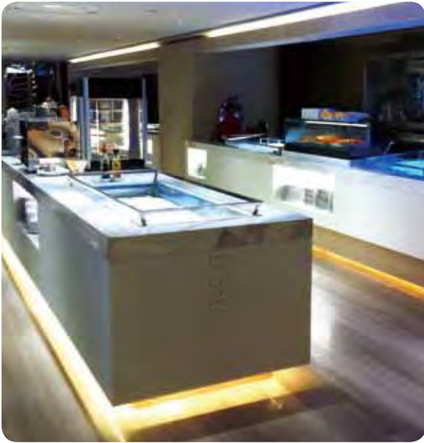
為香港一家酒店進行裝修及翻新工程
