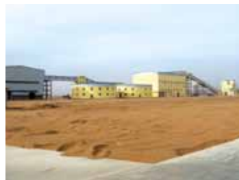
Ceke湿煤处理设施
