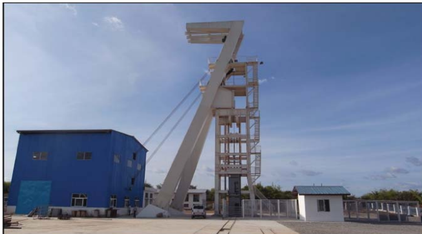
圖7-4：Chambishi 西礦中央副礦井井架
