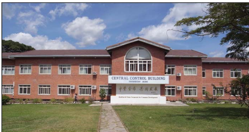
圖12-3：中色非洲礦業辦公樓（「中央控制大樓」）
