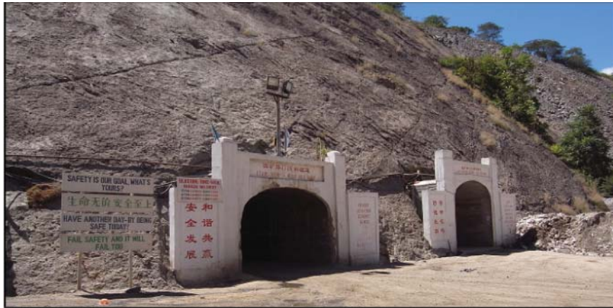
圖7-3：Chambishi 西礦主斜坡入口
