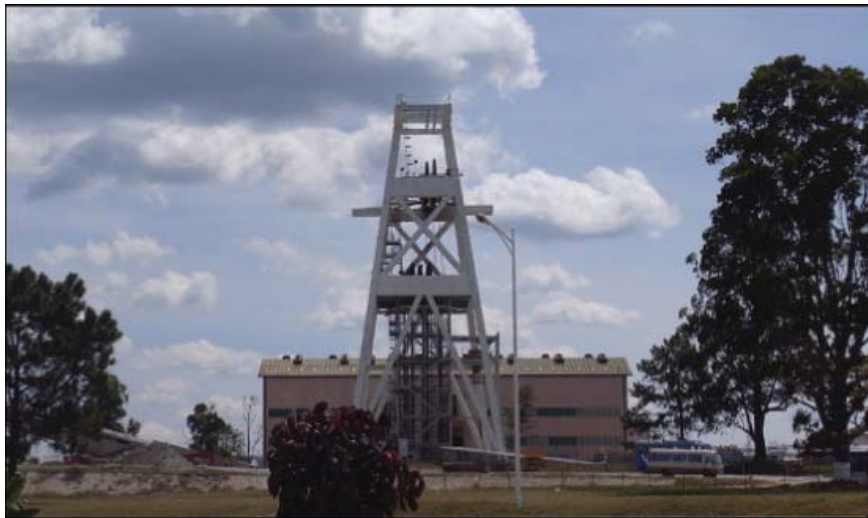
圖7-2：Chambishi 主礦3號礦井概貌
