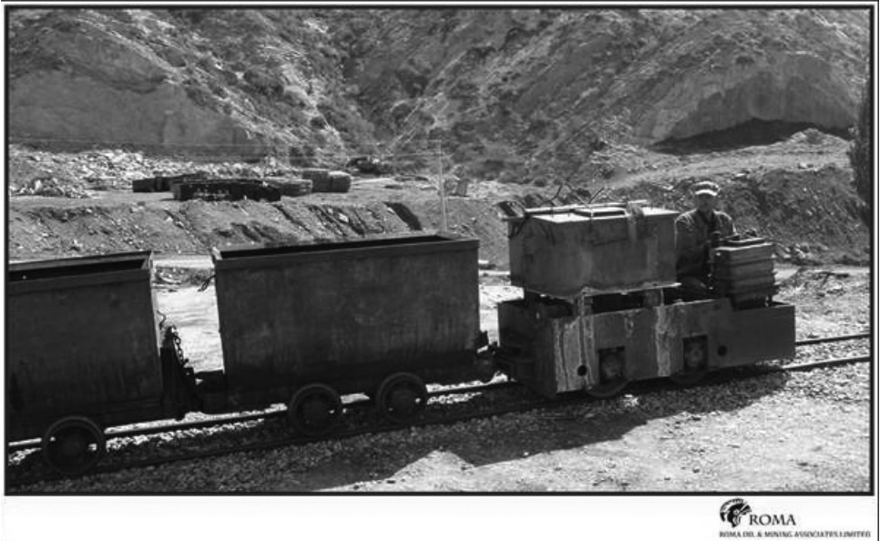
圖13-2 拜城煤礦的電力牽引系統
