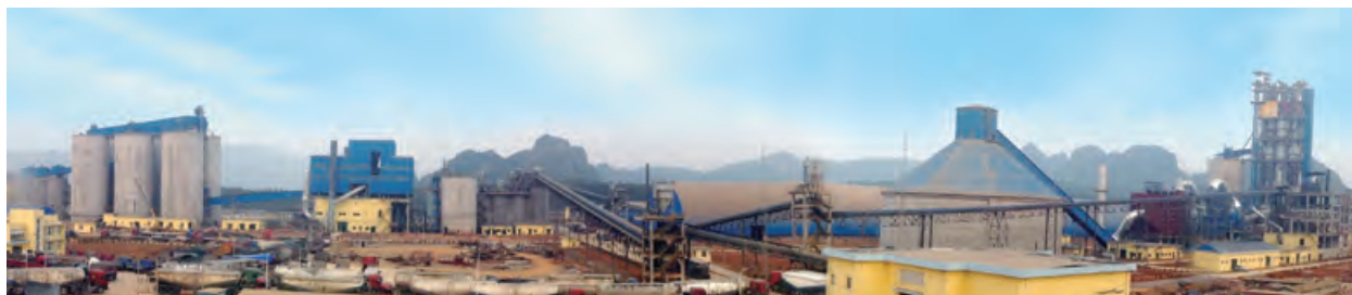
我們位於廣東羅定的水泥生產基地
