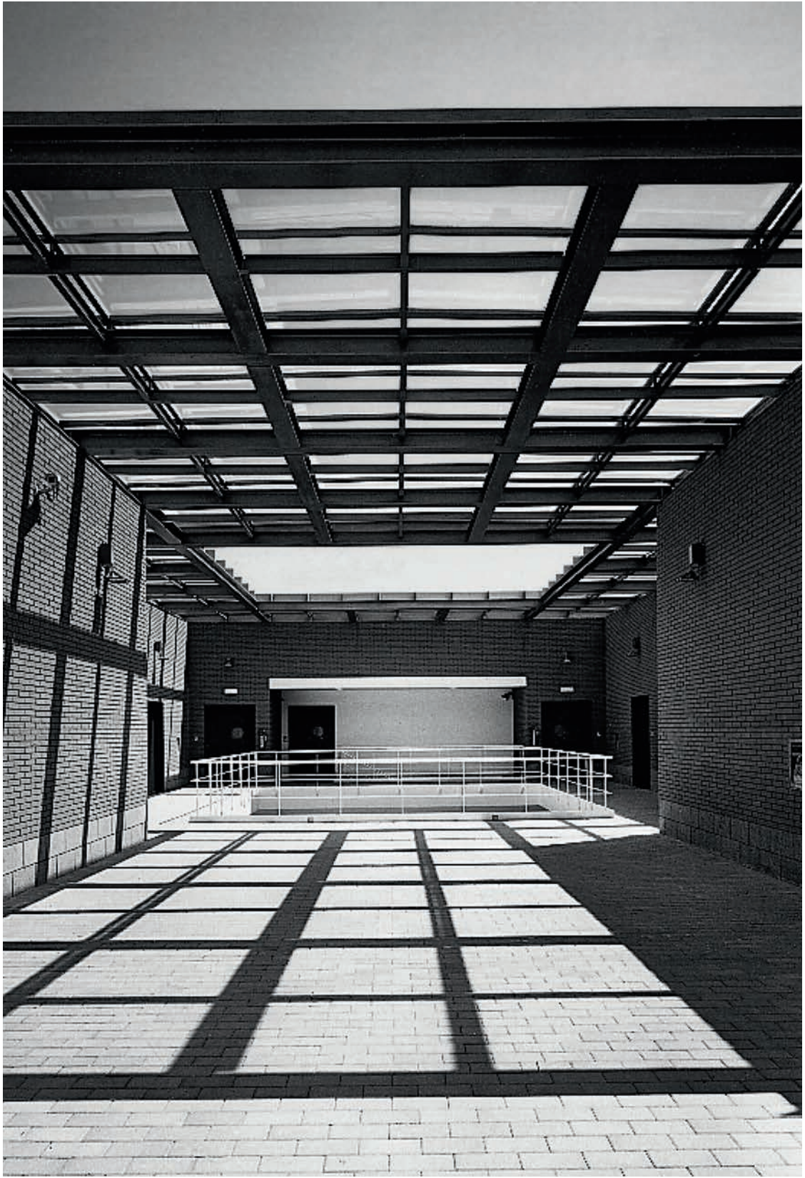
The I.P.I. Amiata facility Piancastagnaio (SI), project by Studio Cerri
