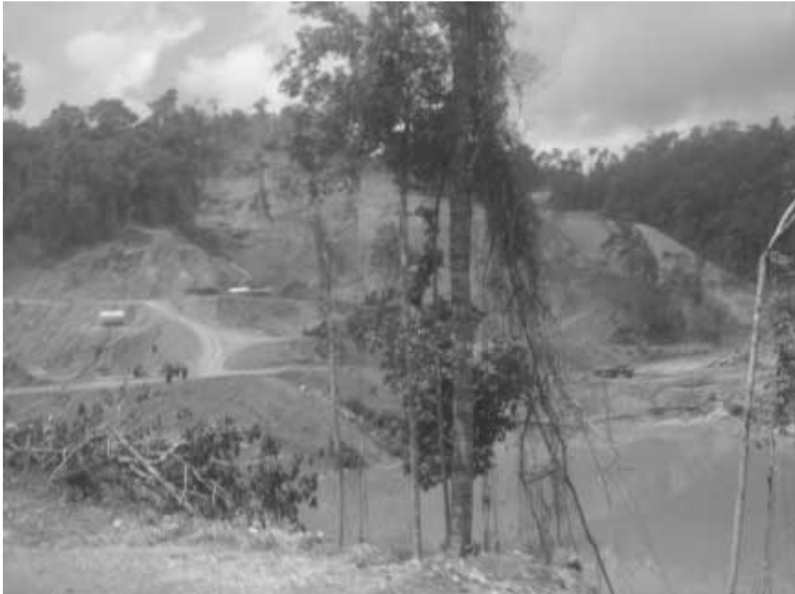
照片5：儲存徑流及排水的蓄水池
