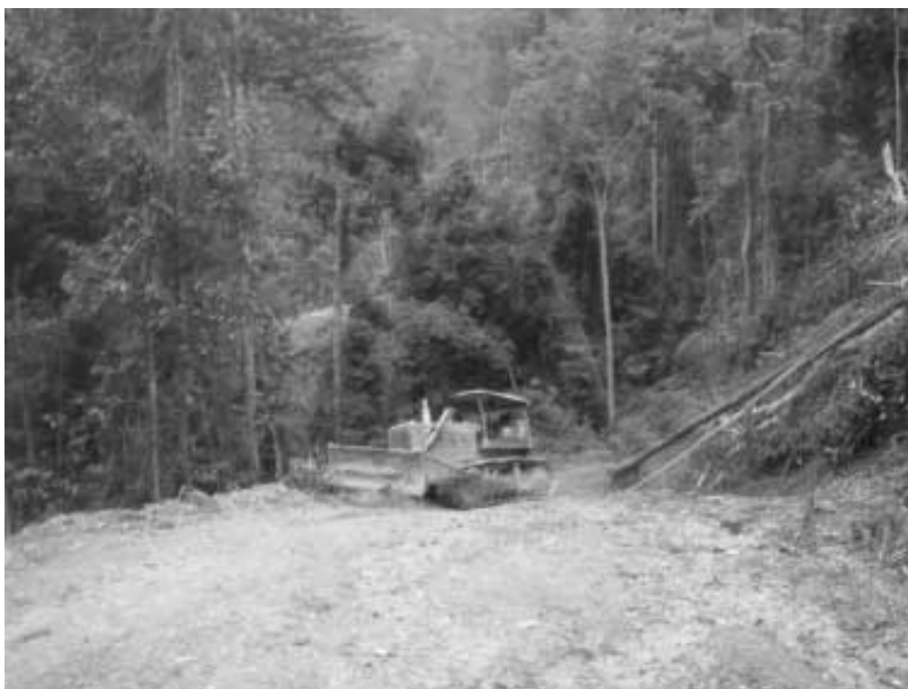
照片2：尚未完成的鑽探交通路線
