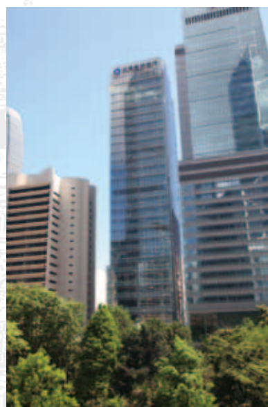
CCB Tower is a commercial development at 3 Connaught Road Central, Hong Kong. 中國建設銀行大廈為位於香港中環干諾道中3號之商業發展項目。
