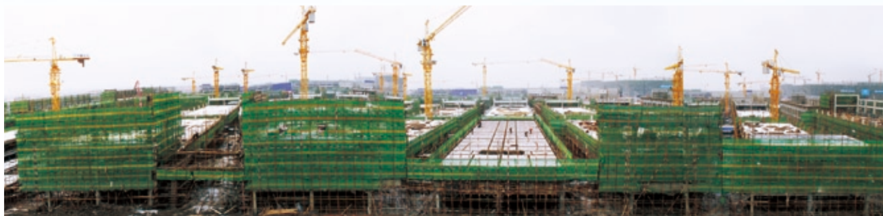
▲ CSC Harbin under construction 在建的哈爾濱華南城
