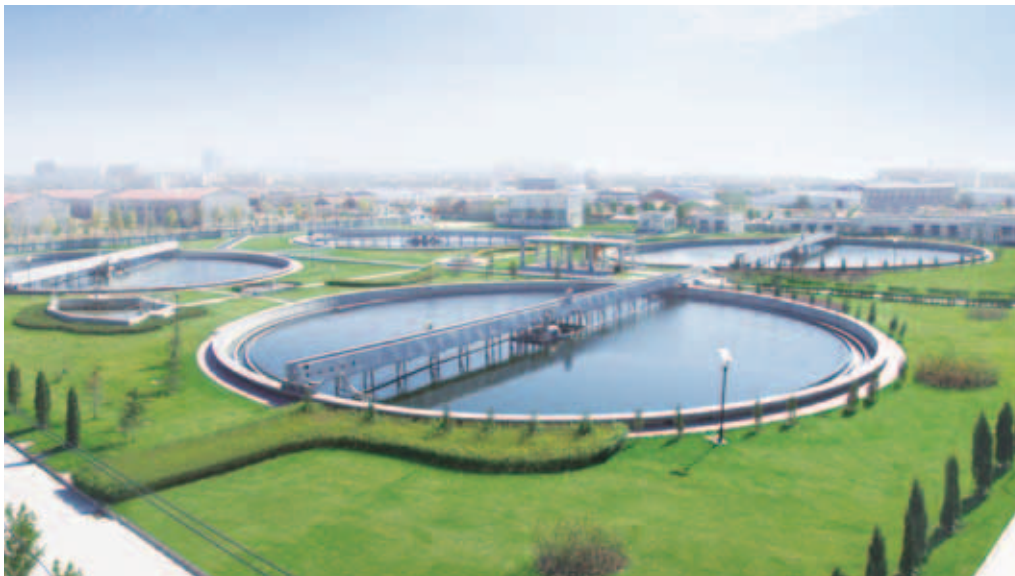
Jinan Waste Water Treatment Project 濟南污水處理項目
