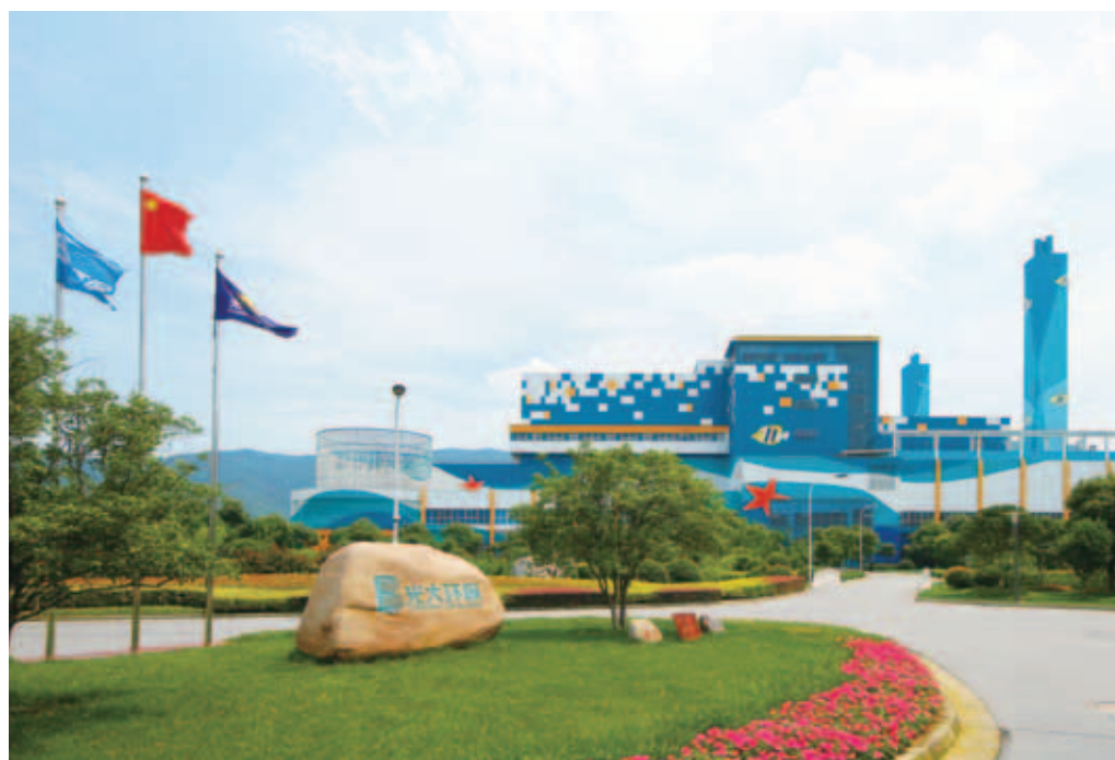
Suzhou Waste-to-energy Project Phase I, II and III 蘇州垃圾發電項目 一期、二期及三期
