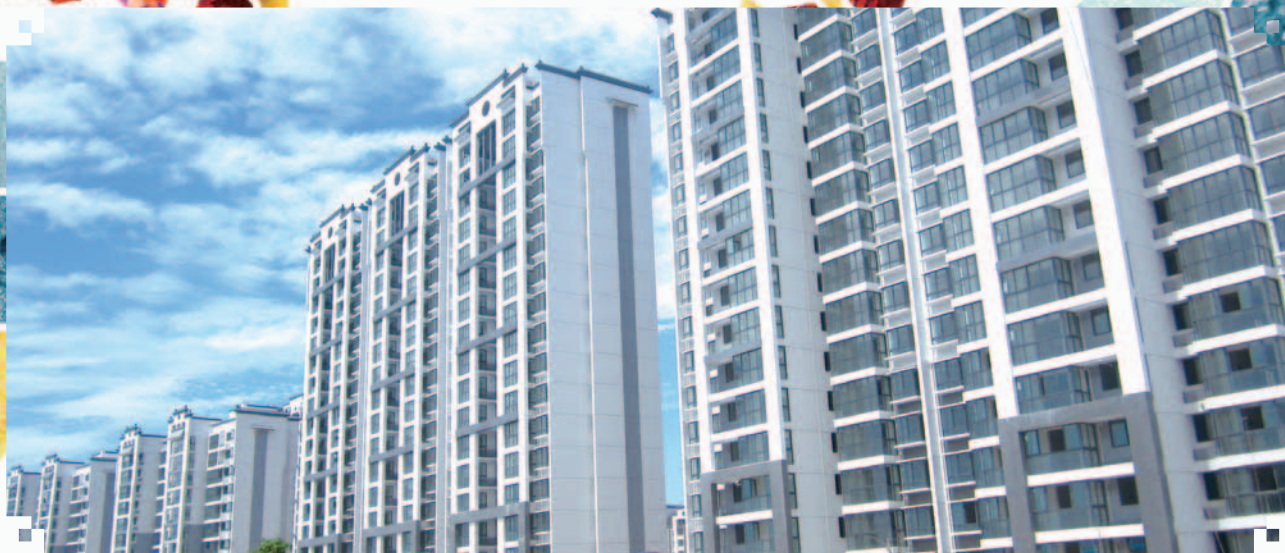
無錫惠山職教員還遷安置房基礎設施
