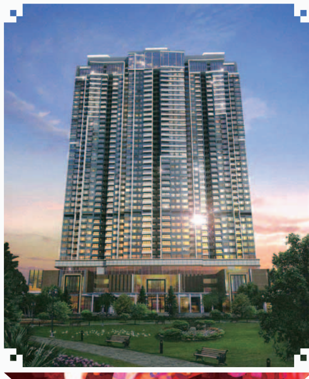
氹仔濠景四期上蓋建造工程
