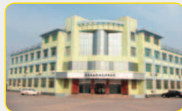
位於河北滄州的油墨廠房 The inks plant in Cangzhou, Hebei
