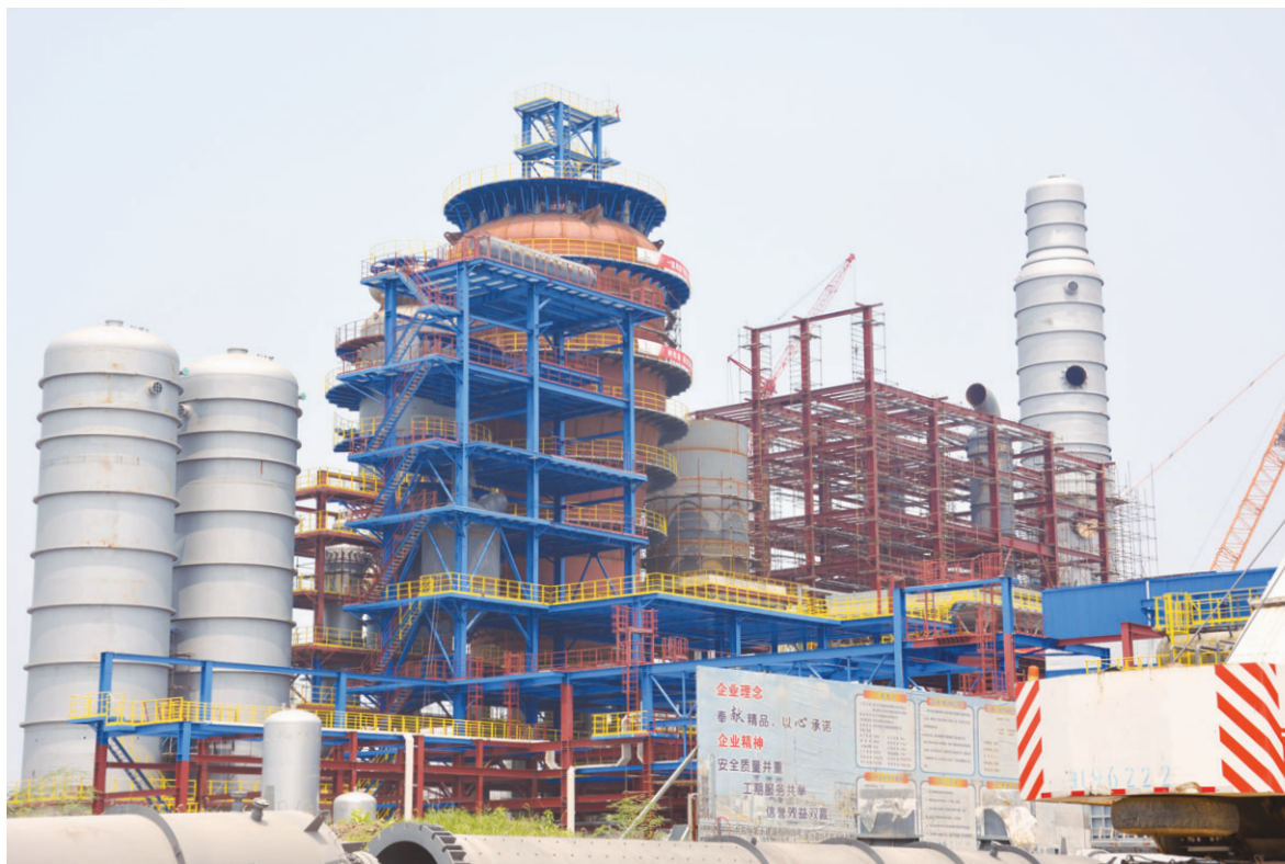
甲醇制烯烴反應器及再生器(於二零一四年八月中)
