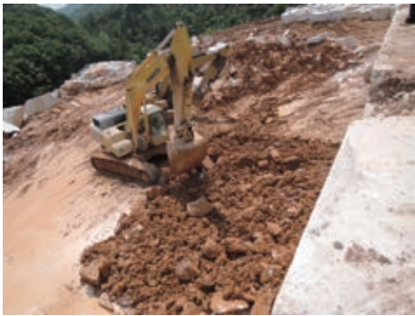
準備以碎石和土壤鋪設的墊層。
