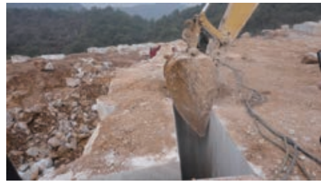
矩形荒料原坯通過前端式裝載機頂翻至墊層上。
