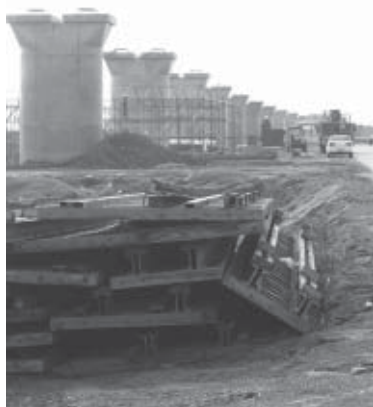
河岸橋柱準備已順利建成
