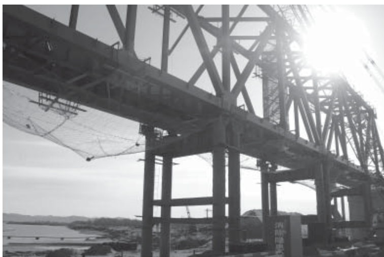
興建跨河大橋的上層結構
