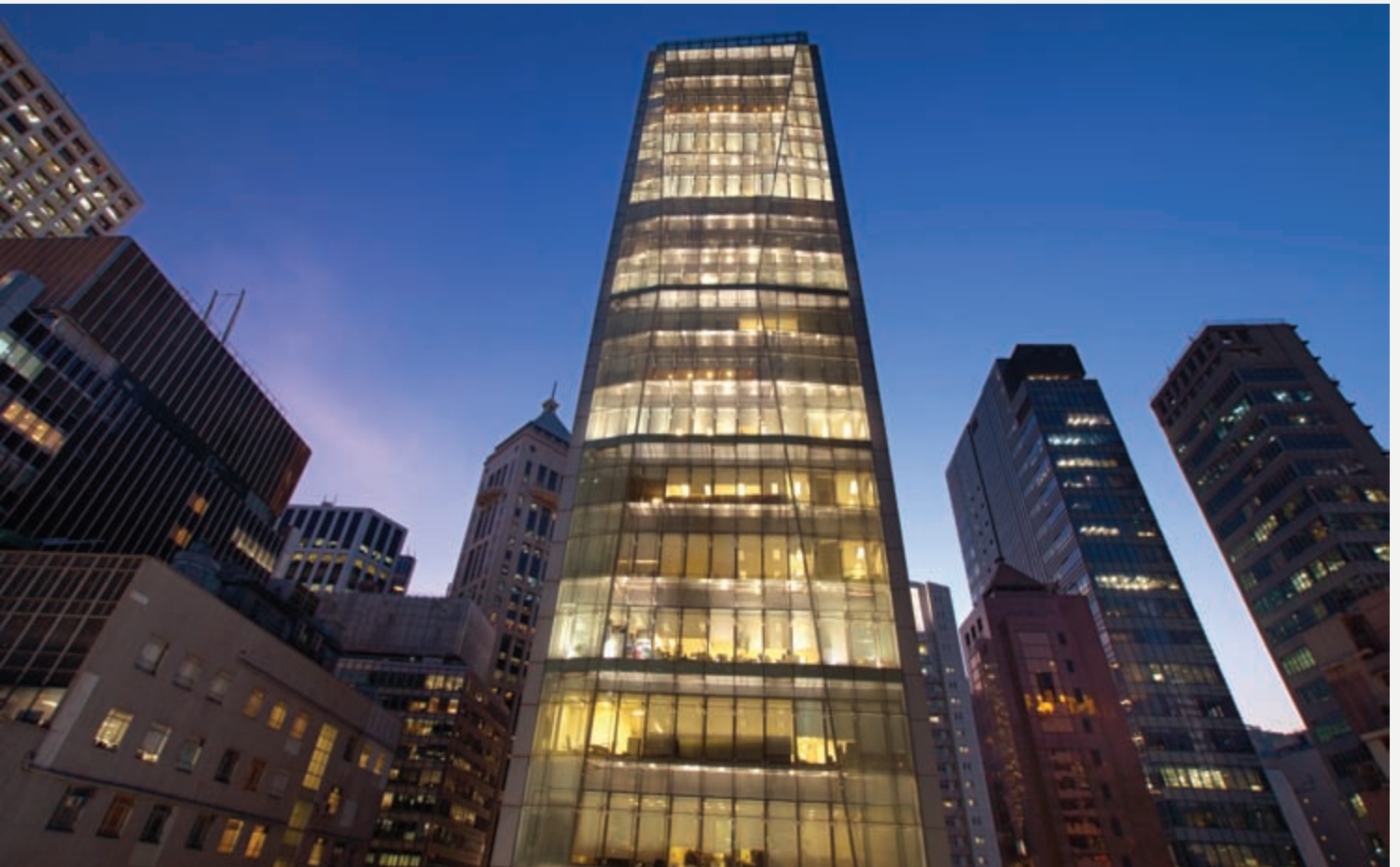
Chong Hing Bank Centre, Hong Kong 香港創興銀行中心
