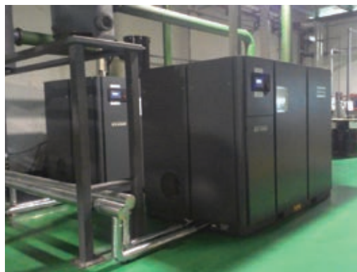
杭州公司真空泵改造項目
