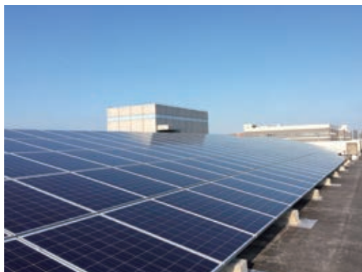
光伏發電項目
