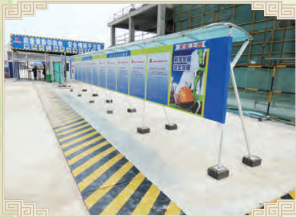
蚌埠禹洲•龍子湖郡項目設置施工區安全宣傳欄，提醒員工注意安全
