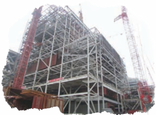
圖註：脫硝系統改造
