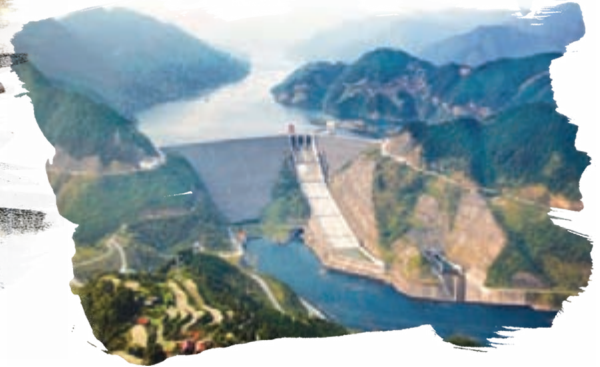
圖註：三板溪電廠主動攔洪補償水量 19.61 億立方米，增發電量 565,000 兆瓦時。
