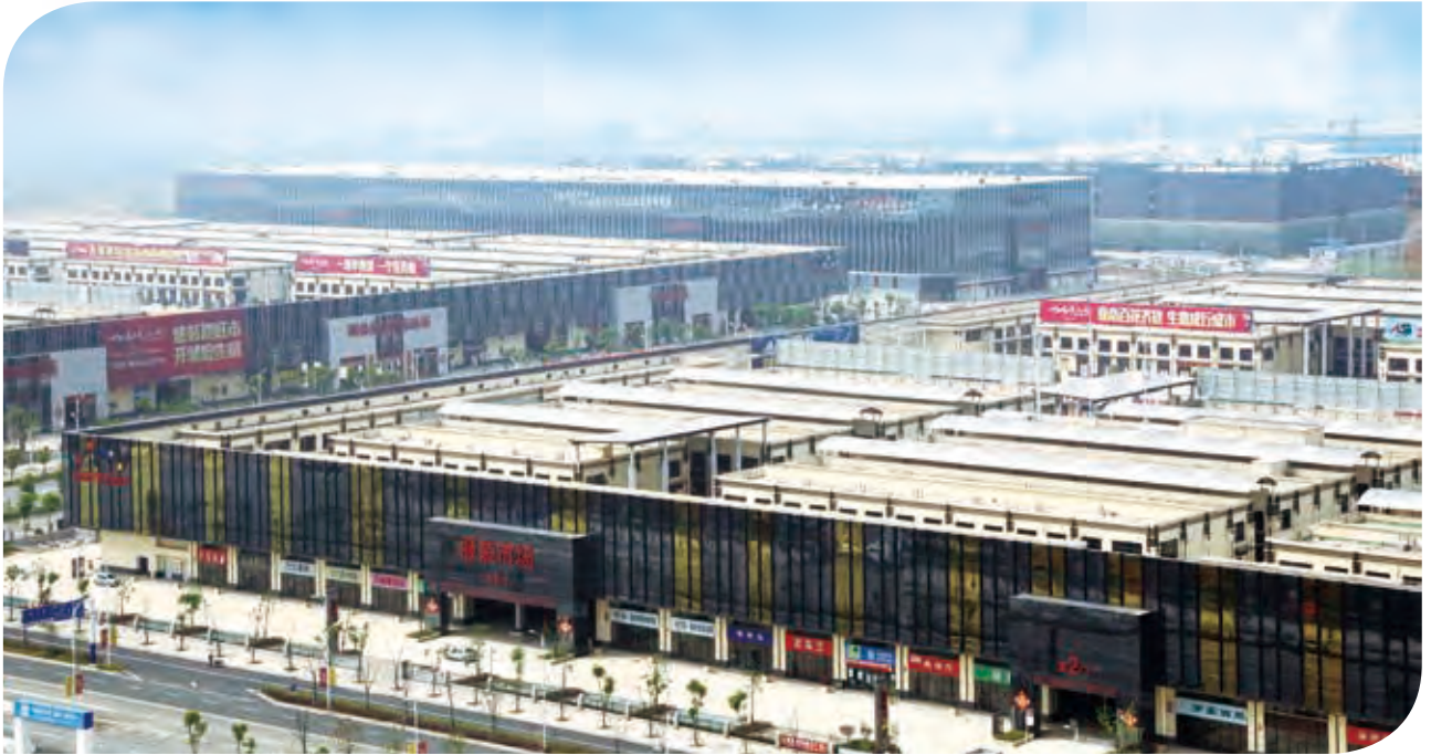
CSC Hefei under construction 在建中的合肥華南城
