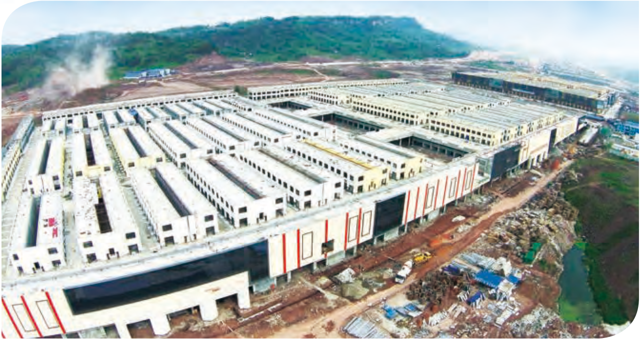
CSC Chongqing under construction 在建中的重慶華南城
