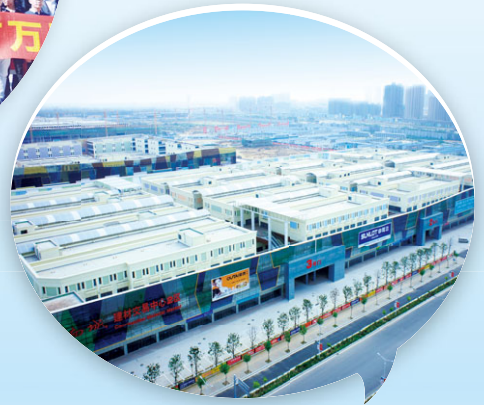
Construction material market in CSC Zhengzhou 於鄭州華南城的建材交易中心
