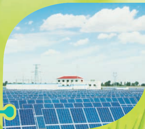
甘肅武威 光伏發電項目
