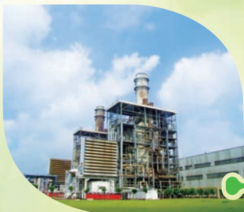
東莞中電 新能源熱電廠
