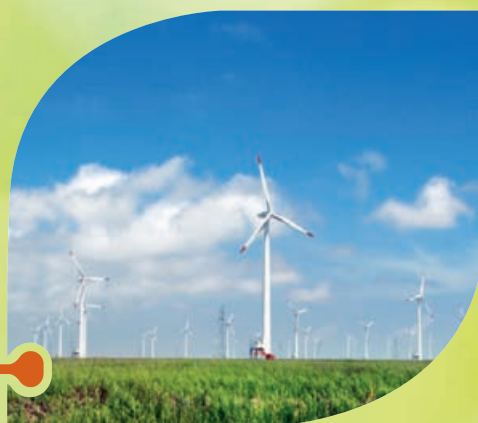
中電大豐 風力發電項目
