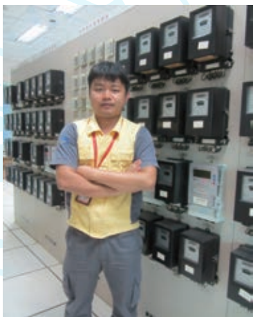
Substation Electrician Wu Tingbiao 變電運行工 吳挺標
