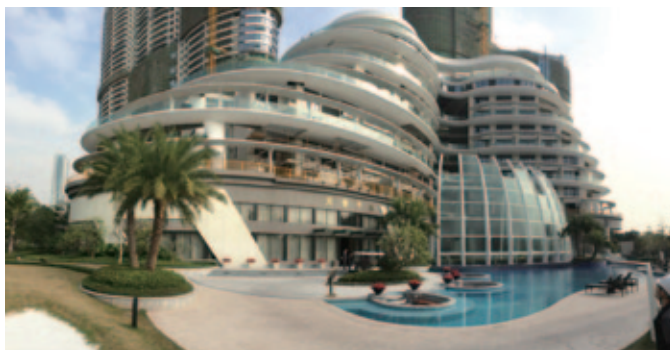
Tower A1 of Skyfame Byland
