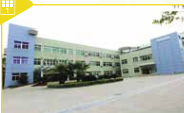
位於廣東中山的油墨廠房 The inks plant in Zhongshan, Guangdong
