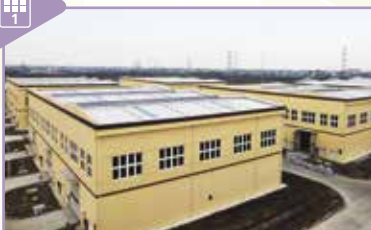
位於上海金山的塗料廠房 The coatings plant in Jinshan, Shanghai
