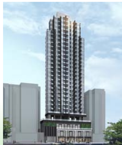
■ 位於九龍深水埗順寧道69至83號之商業/住宅發展項目 - 上蓋建築工程進行中 (*)
