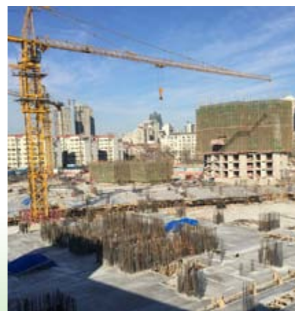
■ 綜合發展項目住宅大樓 — 上蓋工程進行中
