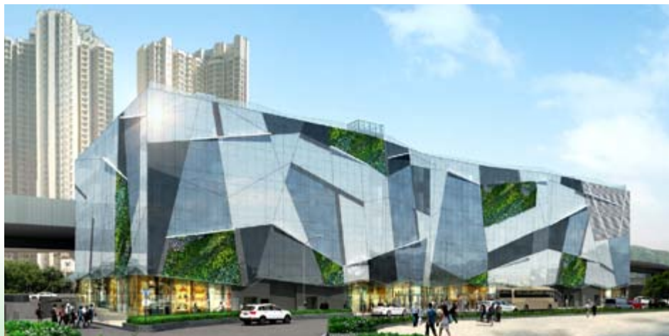
■ 位於新界沙田馬鞍山保泰街沙田市地段第482號之購物商場 - 地基工程已完成 (*)
