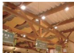
遊戲館內的LED照明
