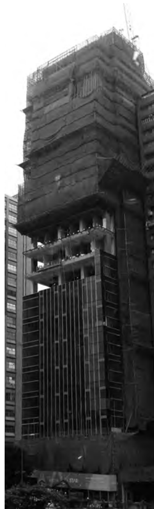
在建的星星中心，並已完成封頂工程
