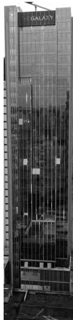
天際中心外部
