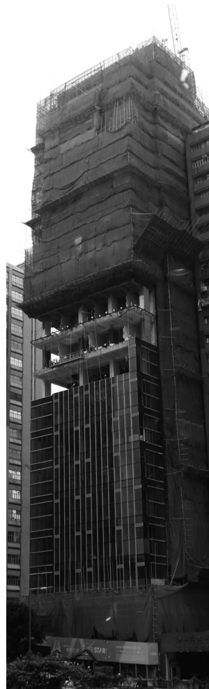
在建的星星中心，並已完成封頂工程
