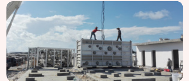
永興島海水淡化項目建設現場
