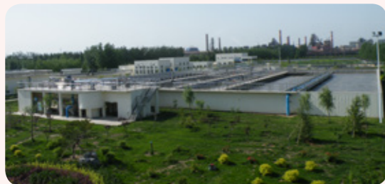
濟南開發區污水廠
