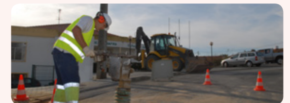
Mafra 項目維修施工現場 2
