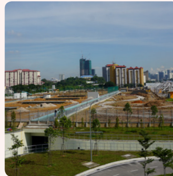
馬來西亞潘岱第二污水處理廠現場
