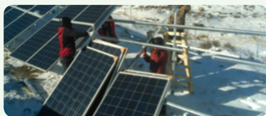
河北蔚縣光伏項目建設現場
