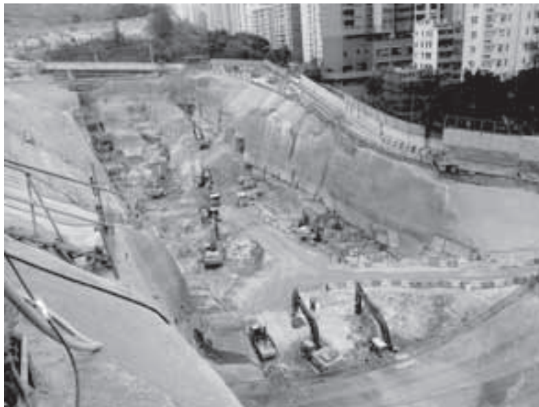
一般土石方工程
