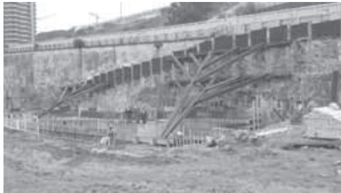
挖掘及側向承托工程
