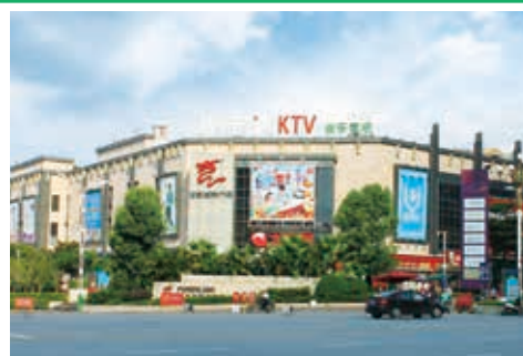
泉州安溪寶龍廣場
