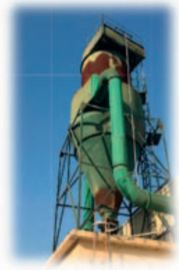
廢氣處理裝置
