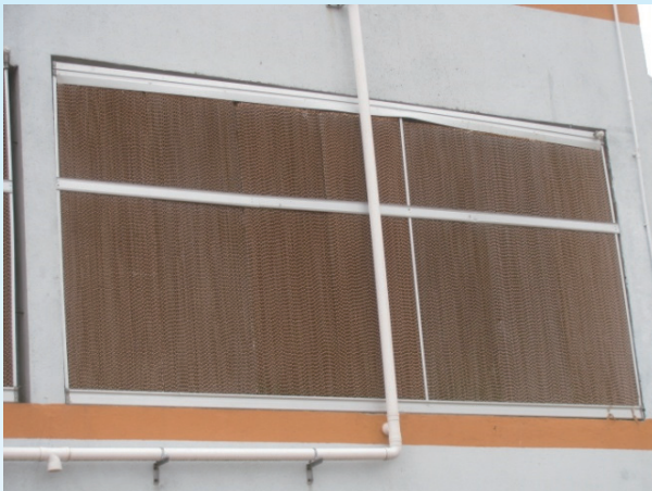
外牆開口處安裝蒸汽冷卻板
