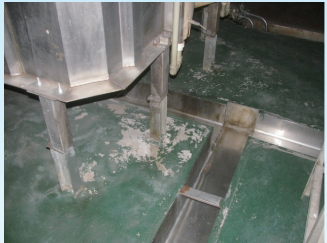
屠宰間內排放廢水的排水溝
