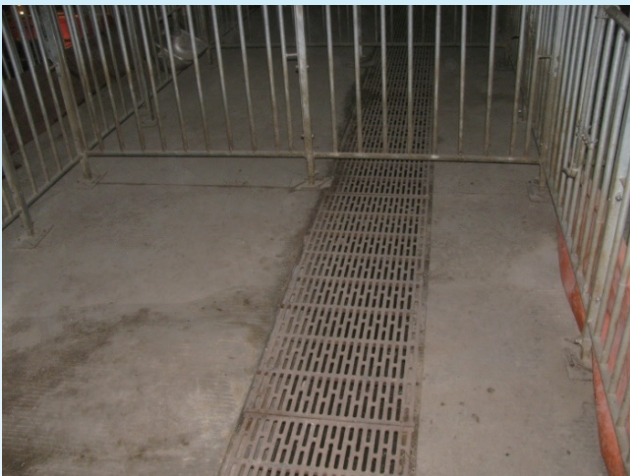
養豬欄內用於收集及排放豬糞的排水渠
