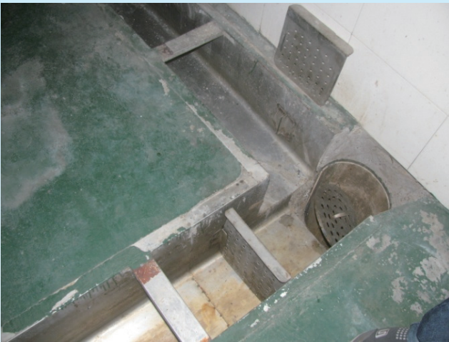
屠宰間內排放廢水的排水溝
