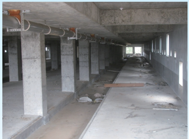
養豬欄內排水渠結構
