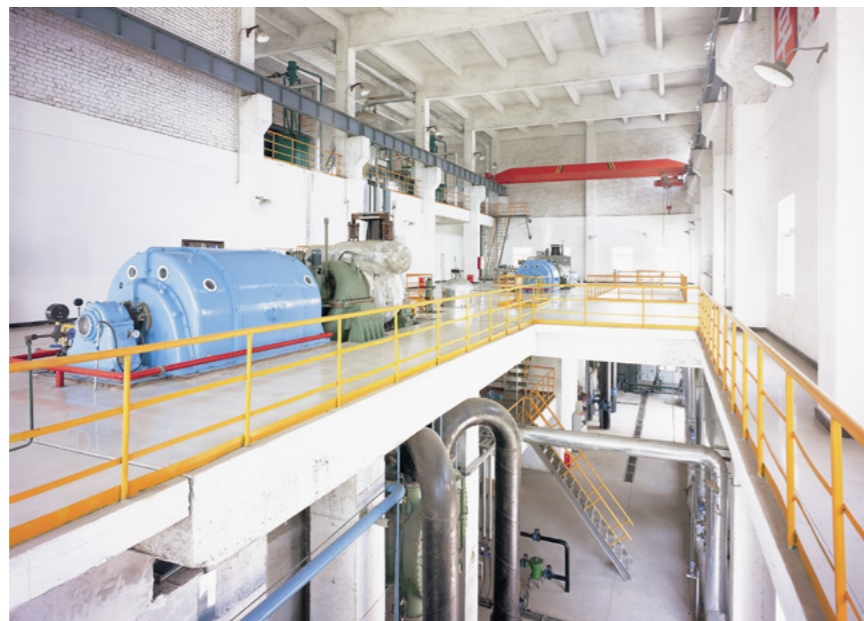
純低溫余熱發電機組
