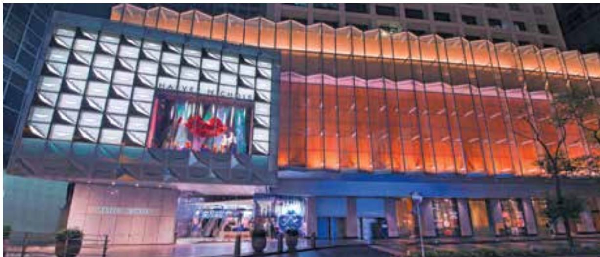
Newly renovated Harvey Nichols store at Landmark, Central, Hong Kong ("Landmark Harvey Nichols Store"). 位於香港中環置地廣場新裝修的「Harvey Nichols」店（「置地Harvey Nichols店」）。
