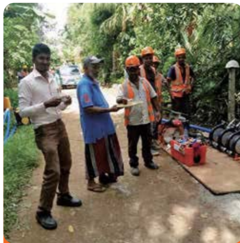
斯里兰卡库鲁内格勒供水和污水处理项目所在地居民给 CMEC 现场作业人员送茶水
