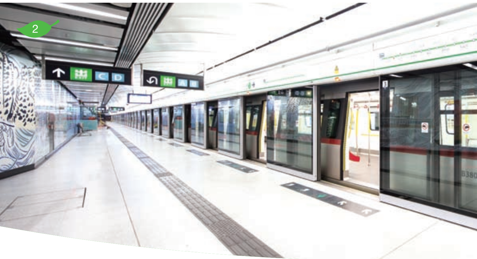
1&2 MTR Contract No. 1002 – Kwun Tong Line Extension: Whampoa Station and Overrun Tunnel 港鐵合約編號 1002 – 觀塘綫延綫：黃埔站及避車隧道建造工程
