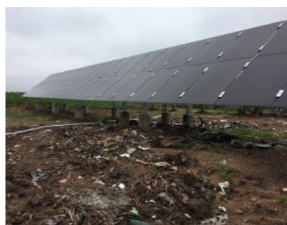
湯原縣光伏扶貧電站項目 圖二
