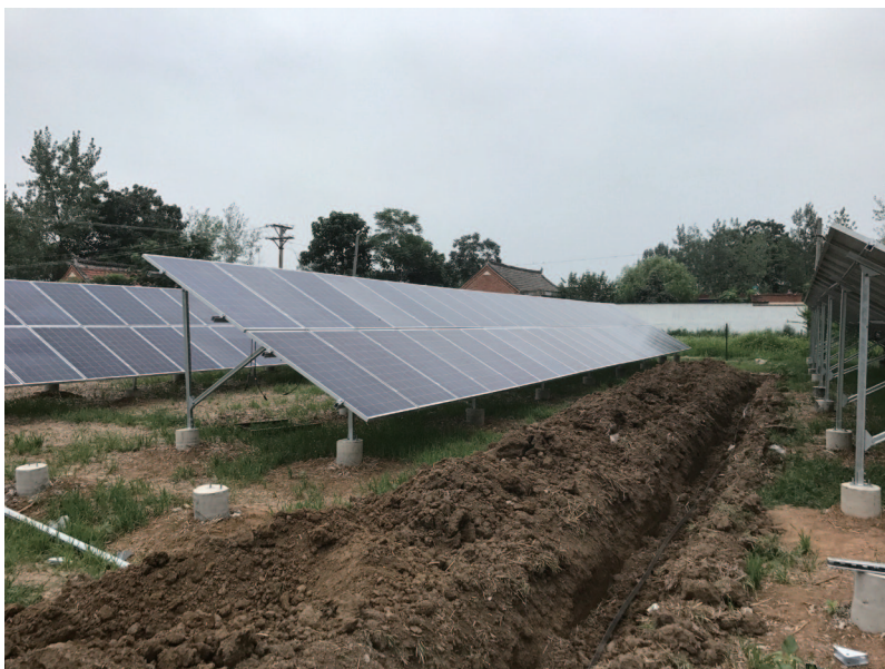
葉縣15MW光伏扶貧項目
