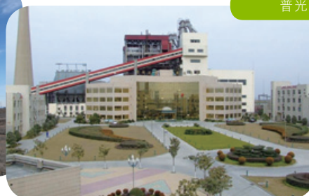
普光燃煤項目
