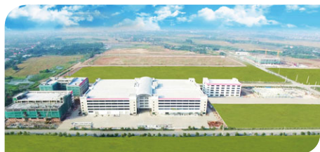
Third Vietnam Facility (Under construction) 第三家越南廠（建設中）
